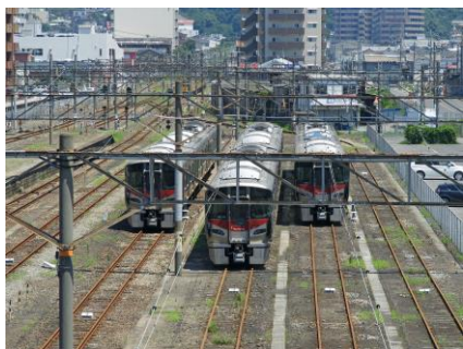
呉線広島駅構内は水没 留置車両はそのままだ
