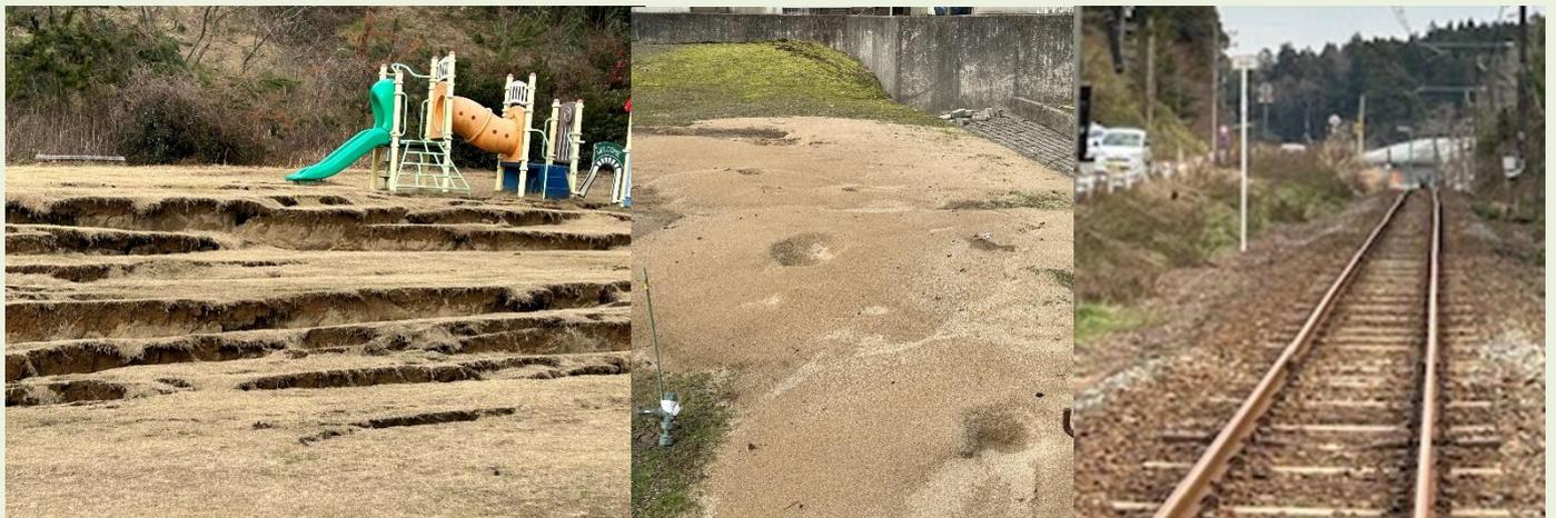
(写真左)元々平地だった公園。地盤が大きく動き段差が生まれ、亀裂も多数発生している。
